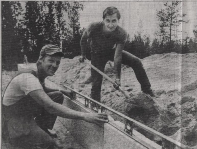
• Ännu finns bara grunden till Björn och Helenes villa. Men redan om en vecka står huset på plats - drypt en dag tar det att resa väggar och takstolar. Björn (t. h.) jobbar själv tillsammans med Erik Lindgren på att jämbetongulast i väg.
