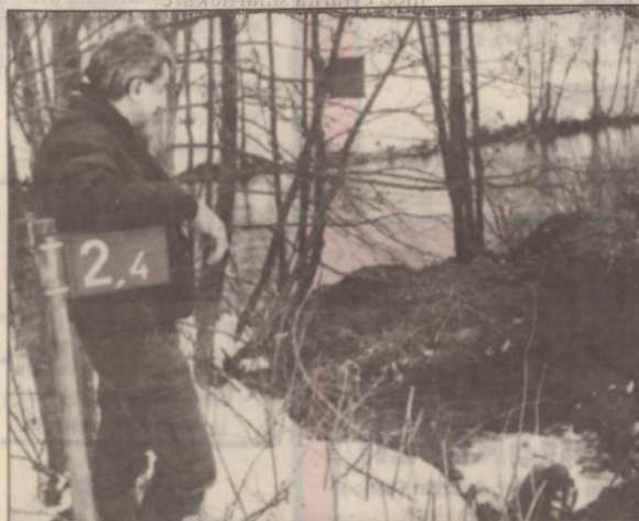
• Kommuningenjör Stig Hägglund iakttar arbetet med att laga huvudledningen med dricksvatten till Nordmaling. Arbetet sker bara ett par meter ifrån Leduån och innebär en risk att vatten från ån strömmar in i det kommunala vattenledningarna.
