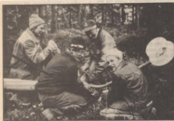
•Jonny Johnsson, Tomas Abramsson, Alvar Johansson och Tore Lindgren jobbar med att ta ner gamla stolpar och plocka ner befintliga armaturer.
