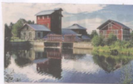
Olofsfors bruk, Nordmaling. FOTO: CURT DAHLGREN
